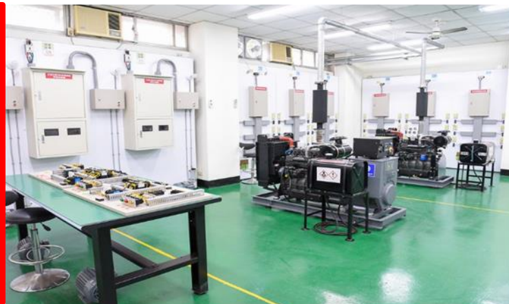
機電設備實習工廠(E棟)
